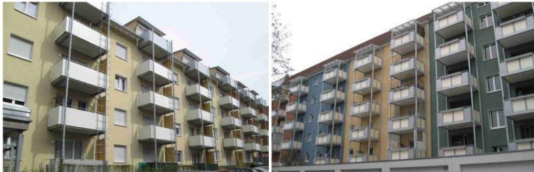
Foto 24 & 25: Beispiel - Balkonlandschaften mit angebotenen Balkonen (links) und wärmebrückenfrei vorgestellten Balkonen rechts. Quelle: ebök
