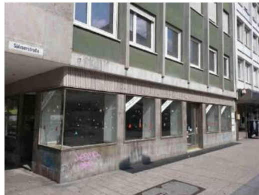
Foto 8: Leerstand in der Sülmerstraße vor Umbau
