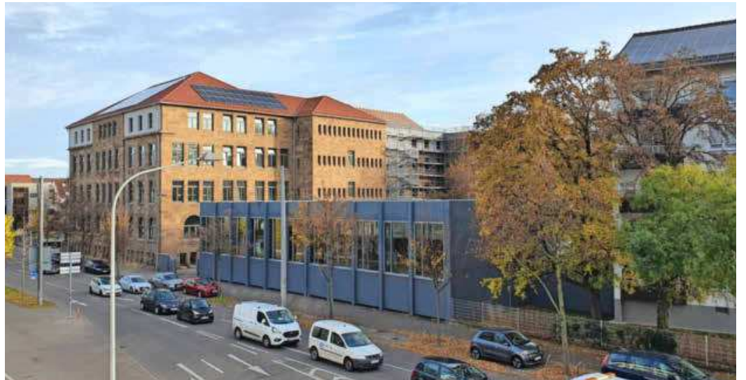
Königlich: Beiden neuen Decken handelt es sich um ein spezielles Leichtbausystem. Dieselben Decken wurden auch im Heidelberger Schloss eingebaut. Foto: Stadt Heilbronn
