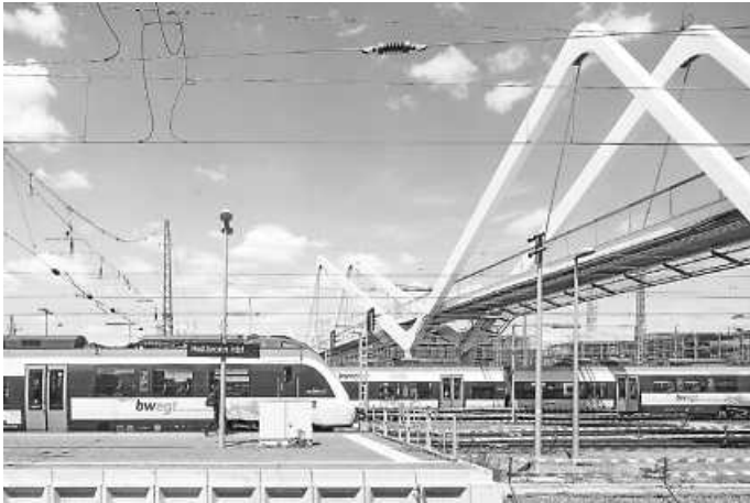
Die Buga-Brücke überspannt die Gleise des Heilbronner Hauptbahnhofs. Foto: Fotografie Dietmar Strauß
